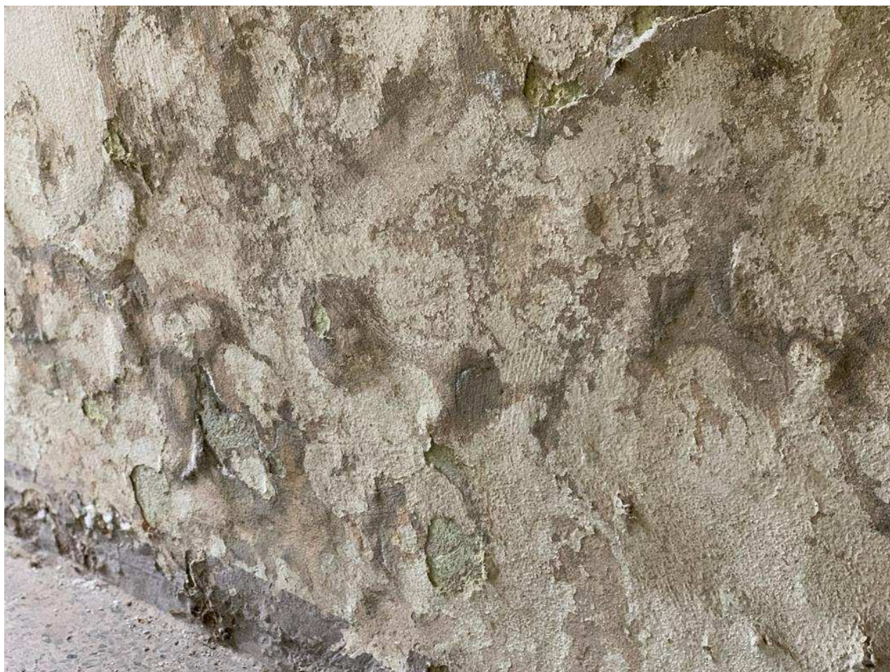
Malta cementizia e formazione di efflorescenze saline
