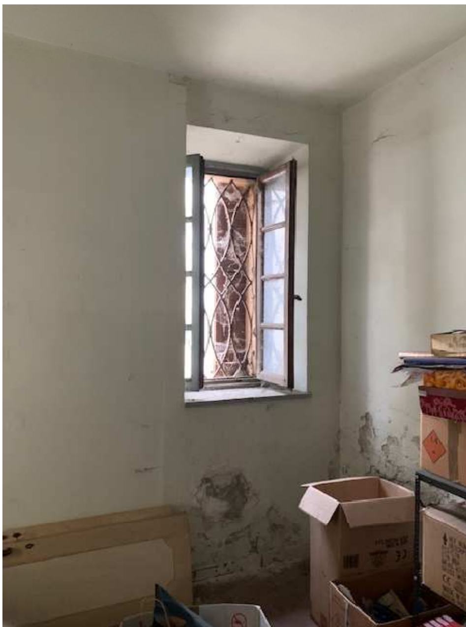
Murature a base cementizia e con presenza di efflorescenze saline
