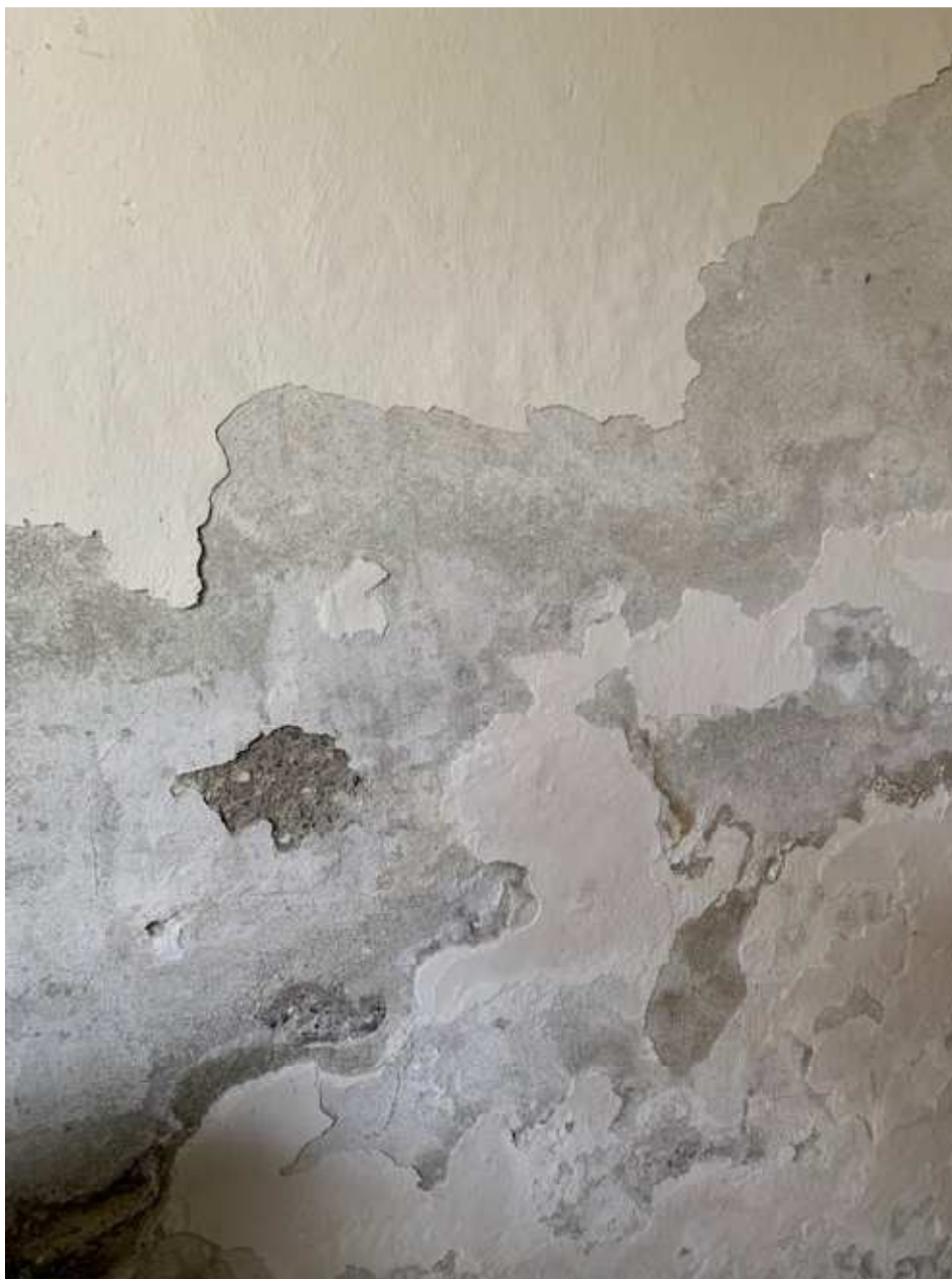
Murature a malta cementizia e formazione di efflorescenze saline
