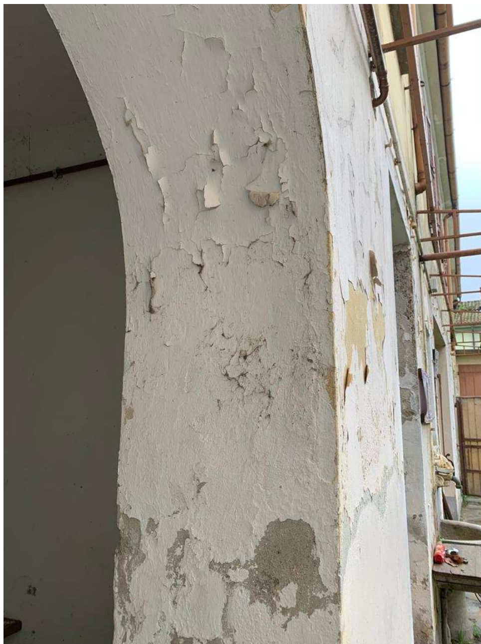
Particolare ammaloramento intonaco
