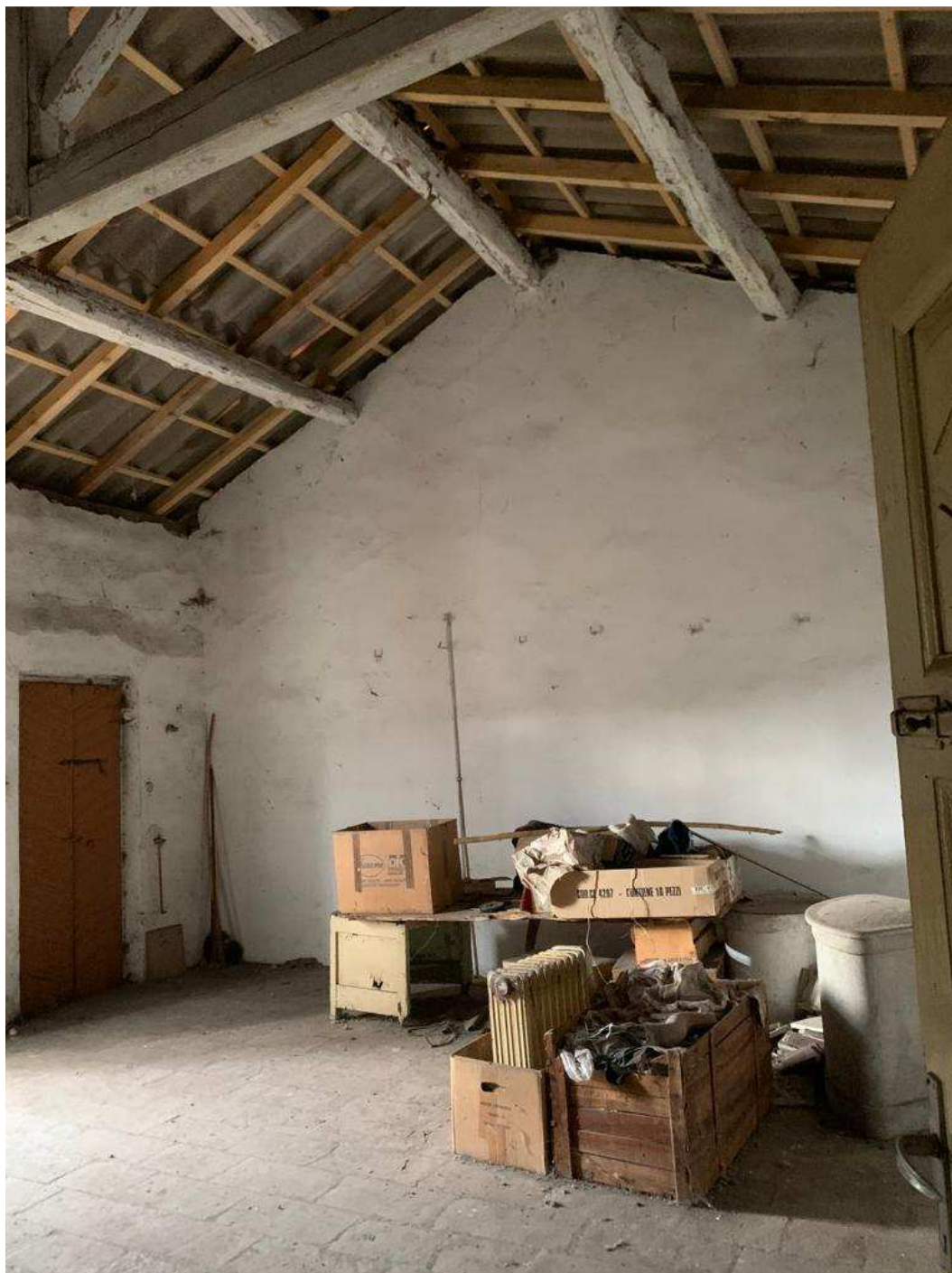
Sottotetto con travetti di recente fattura e grande orditura con travi originali
