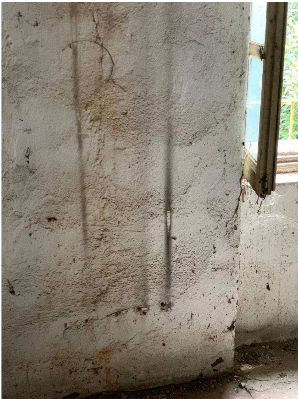
Murature originale trattate a rinzaffo spatolato effetto rustico dipinto con prodotto lavabile per interni
