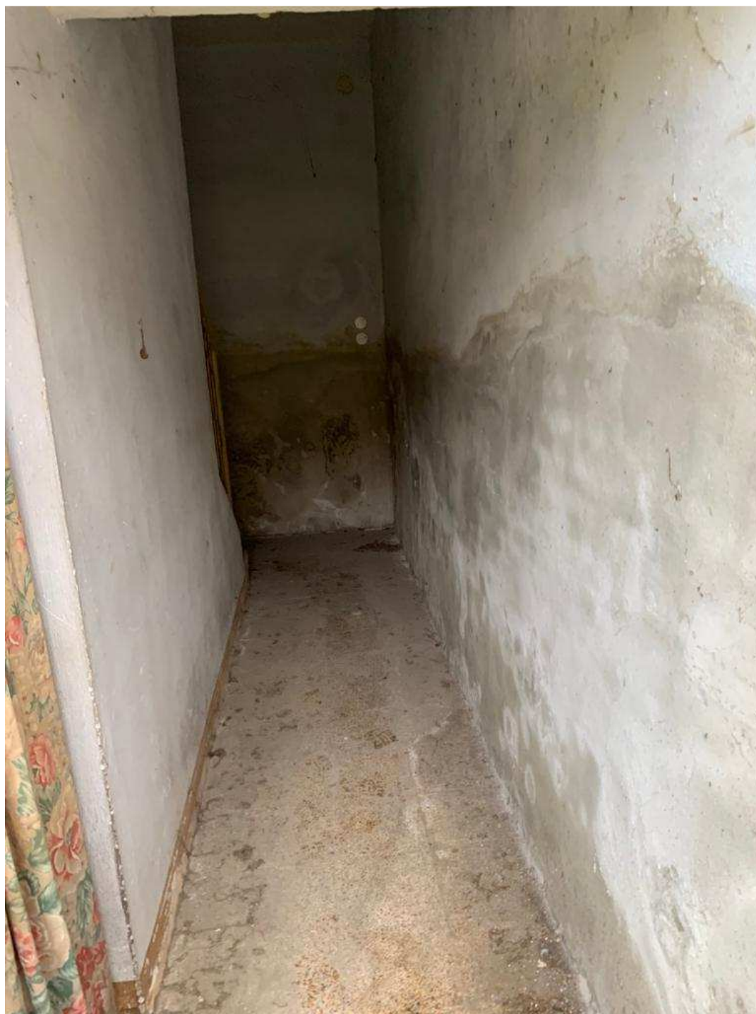
Murature cementizie con forte presenza di umidità e formazione di Sali
