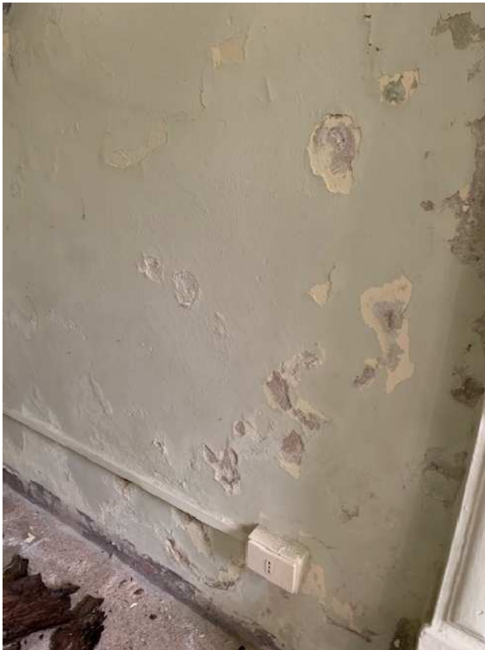
Stato precario delle murature in malta a base cementizia
